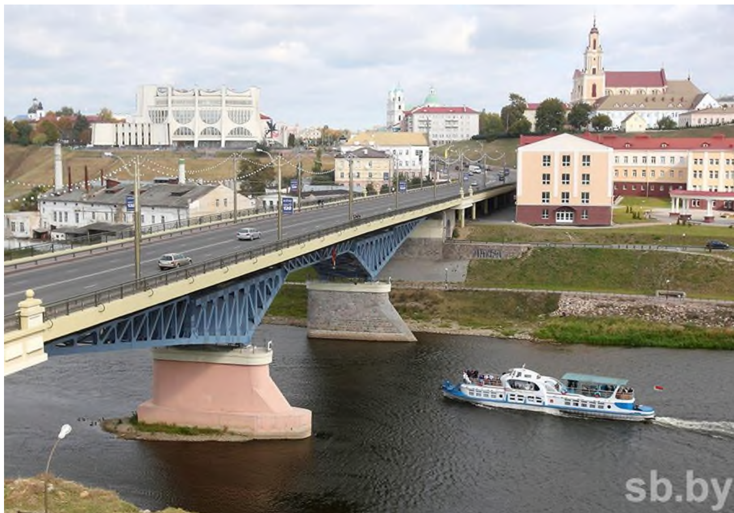
Реконструкция Старого моста — особая гордость гродненских строителей.
