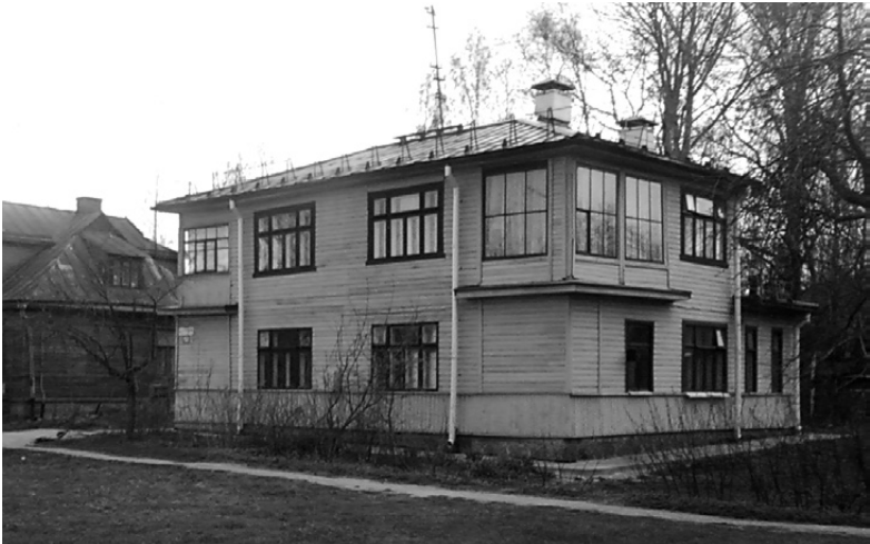
Забудова 1930–х гг. на вул. 17 верасня. Паступова нішчыцца.
