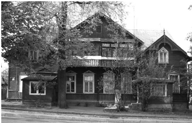
Пякарня Любэга (вул. 17 верасня,8). 24.09.2009 г. пажар знішчыў другі паверх, у выніку дом быў знесены.
