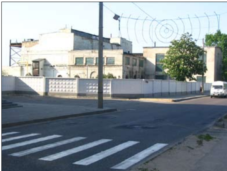
Электрастанцыя па вул. Будзённага.
