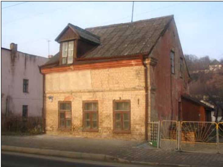
Дом па вул. Падольнай, 38
