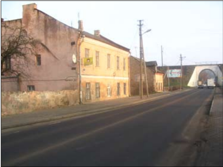
Дом па вул. Падольнай, 34
