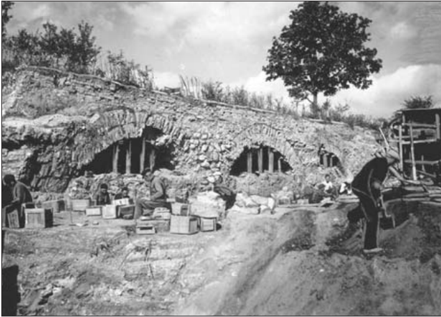
Укрепление откосов Замковой горы и освобождение древних стен от напора земли. Гродно, 1930-е гг.
