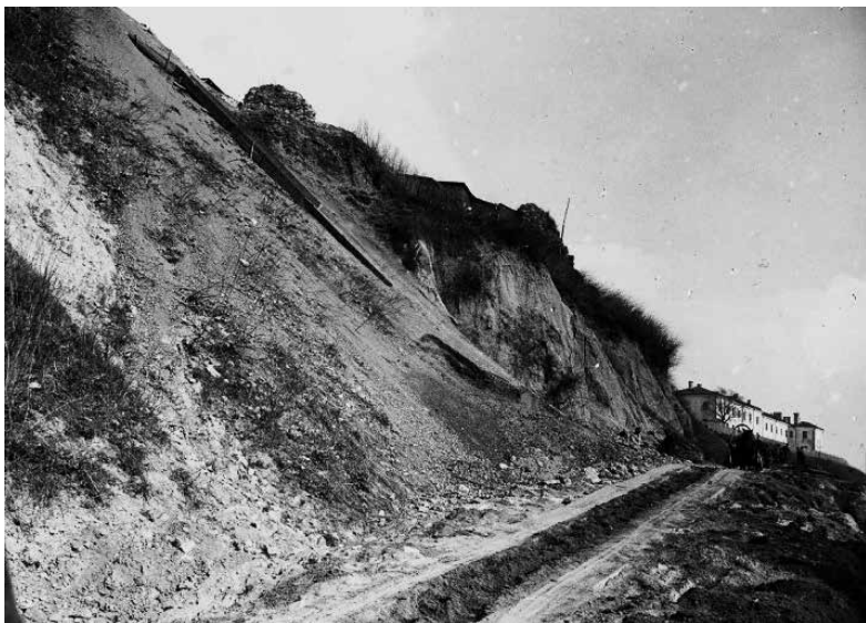
Ремонт склона горы Старого замка. Вторая половина 1920-х гг.
