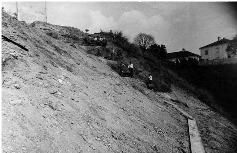
Ремонт склона горы Старого замка. Вторая половина 1920-х гг.
