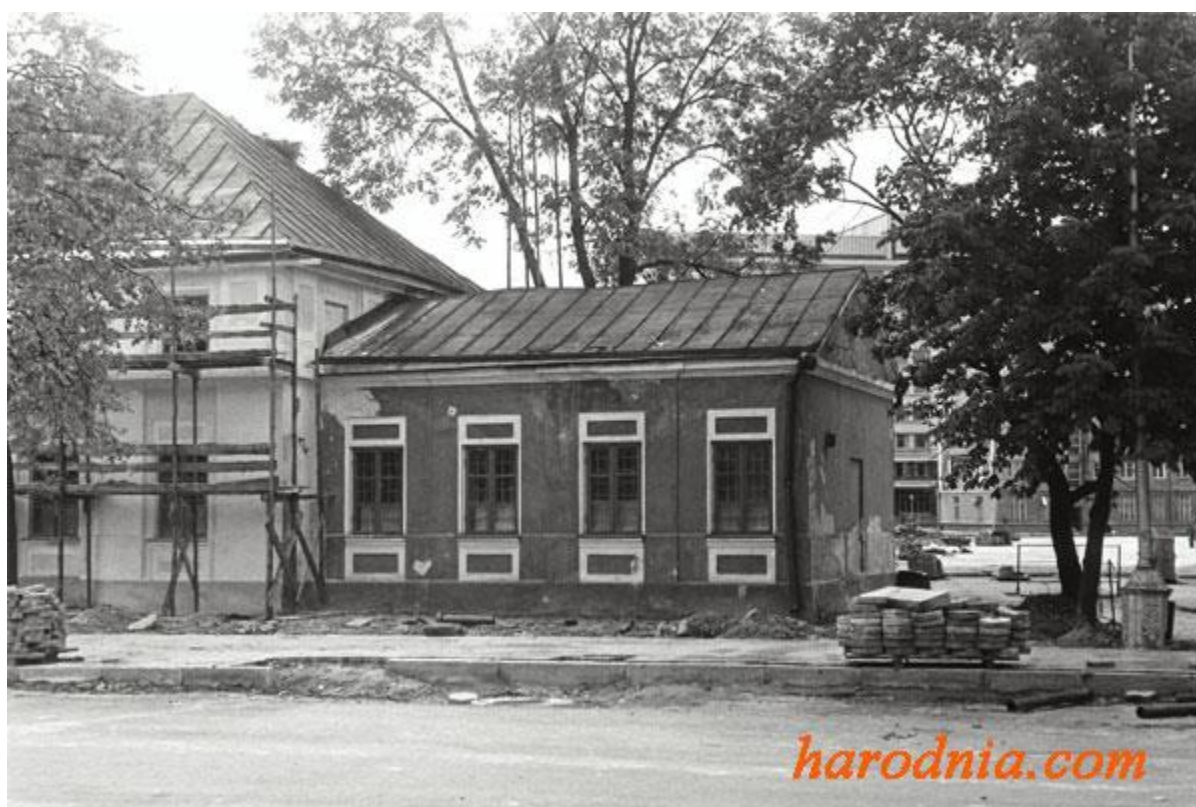
Здание архива во время реконструкции. 1987 г.
