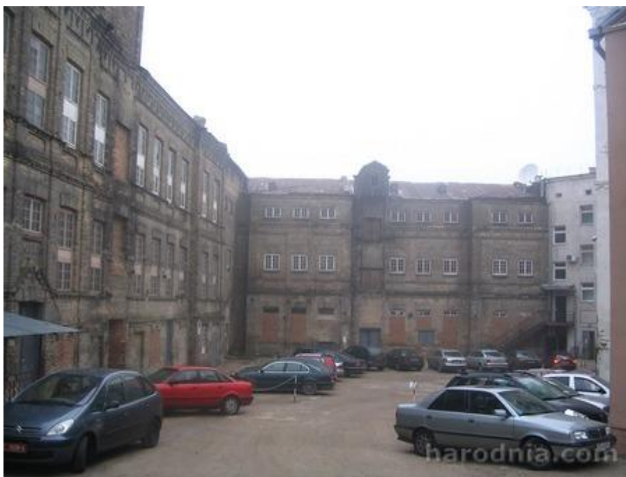
Карпусы фабрыкі Шэрэшэўскіх па вул. Будзёнага.
