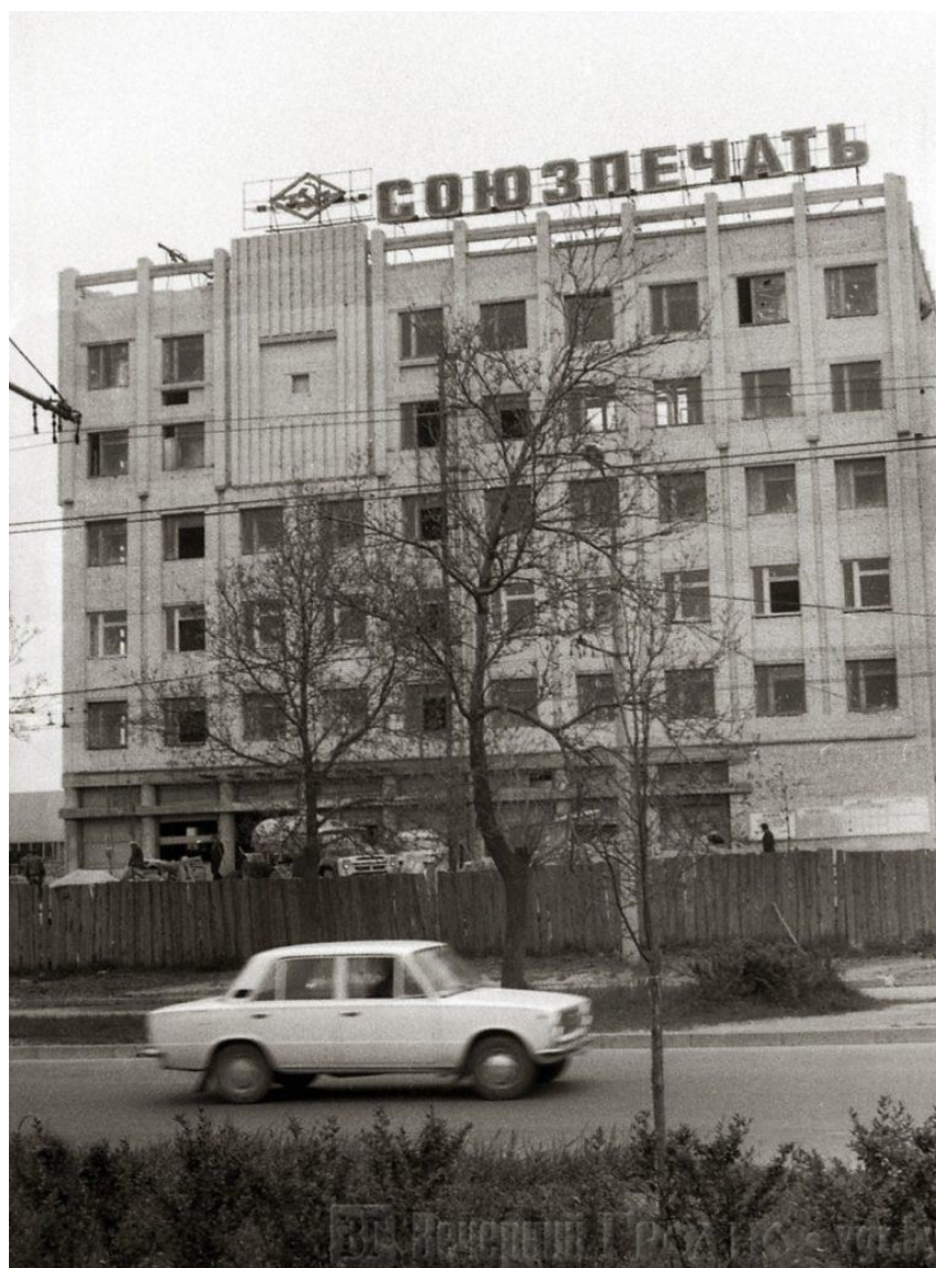
Строительство здания почты на ул. Горького.
