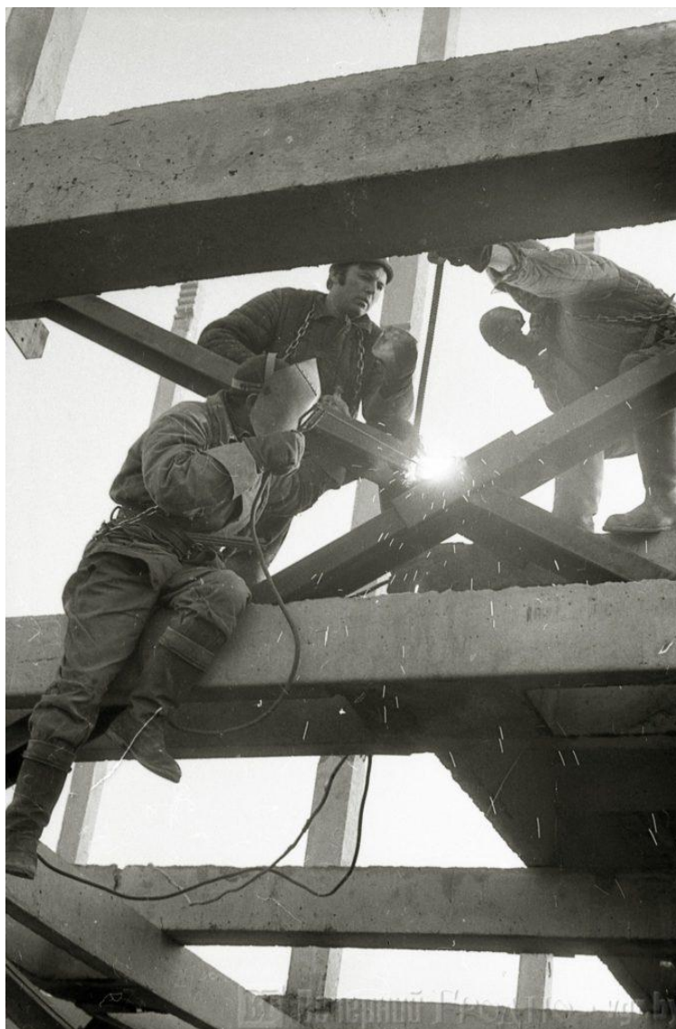
На строительстве больницы Скорой помощи
