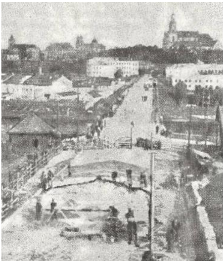
МОЩЕНИЕ БУЛЖНИКОМ МОСТОВОЙ, 1935 ГОД
